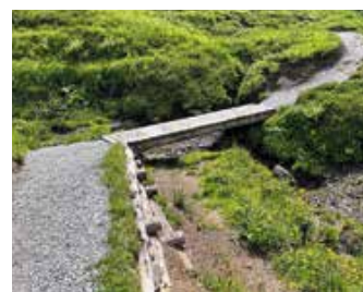
Erfolgreiche Wegsanierung mit neuem Holzübergang
