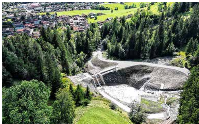
Die Murfangssperre oberhalb von Vorderhindelang soll vor alpinen Gefahren schützen. Foto: Panther Media/Wasserwirtschaftsamt Kempten
