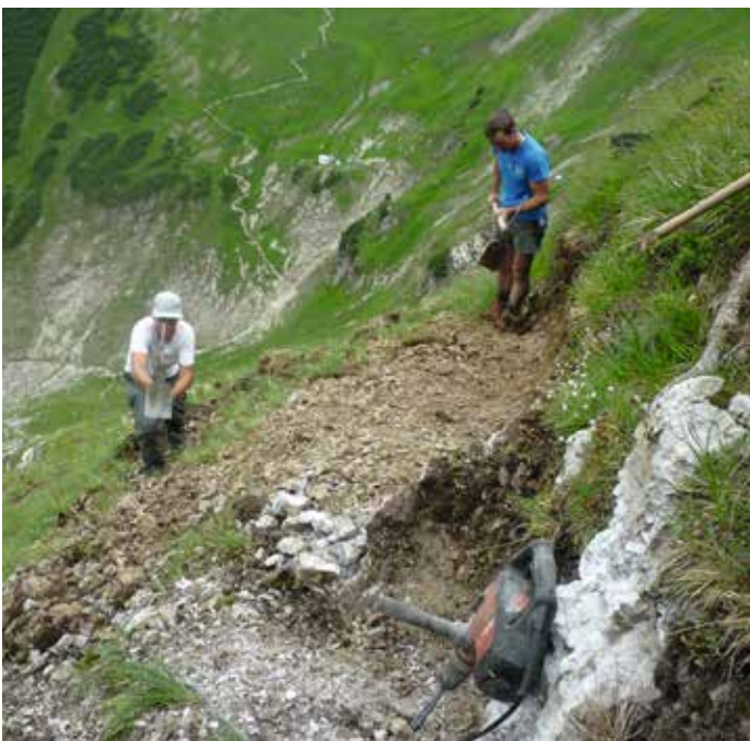
Bei Wind und Wetter eine schweißtreibende Arbeit: Bei den Wegebaumaßnahmen ist auch im steilen Gelände Muskelkraft gefragt
