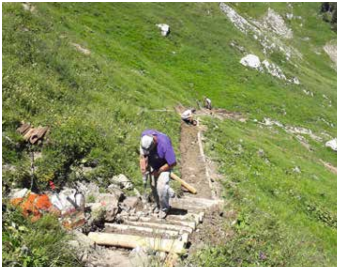
Die neuen Treppen werden mit Hartholz angelegt und sind auf eine besonders lange Haltbarkeit ausgelegt
