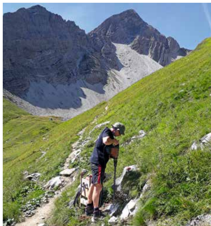
Unterhalb der Bockkarscharte wurde die neue, gelbe Beschilderung montiert. Dabei waren teils auch neue Schilderpfosten und Fundamente notwendig
