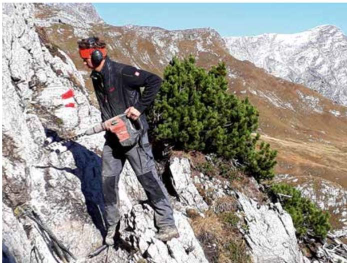
An einigen neuralgischen Stellen werden Seilpassagen nachgebessert und Eisenstufen getauscht.
