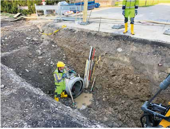
Sanierung der Rainbühlgasse/Richard-Mahn-Straße.
