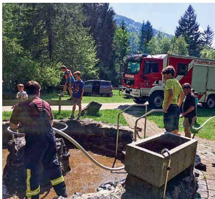
Ein Dank an die Freiwillige Feuerwehr Vorderhindelang für die Reinigungsaktion vor der Sanierung!
