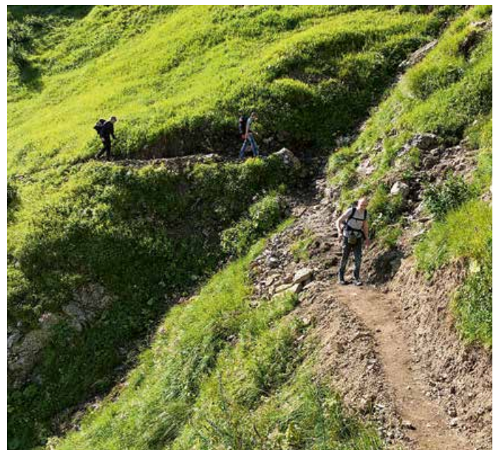
Loses Erdreich wurde beseitigt.
