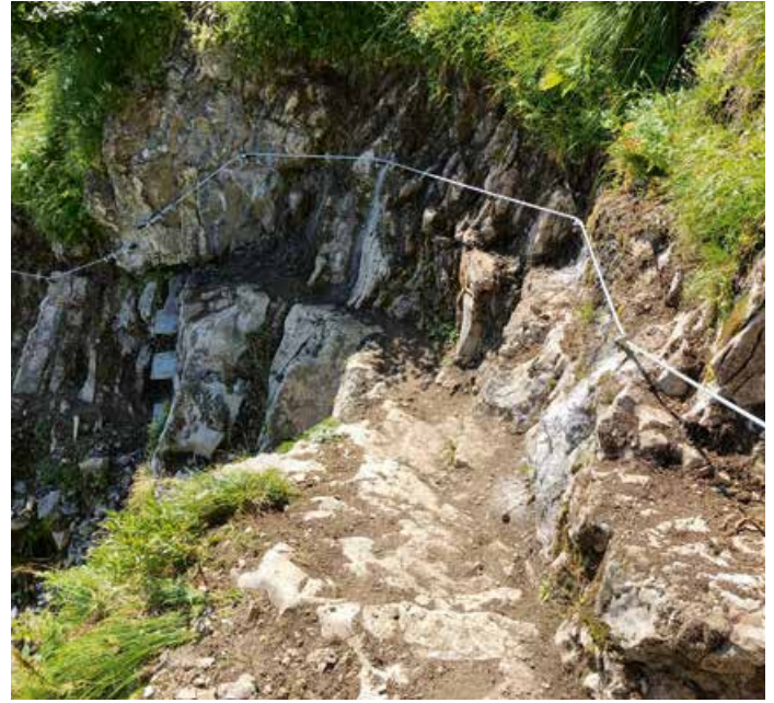
Insgesamt wurden 150 m Seilversicherungen eingebaut.
