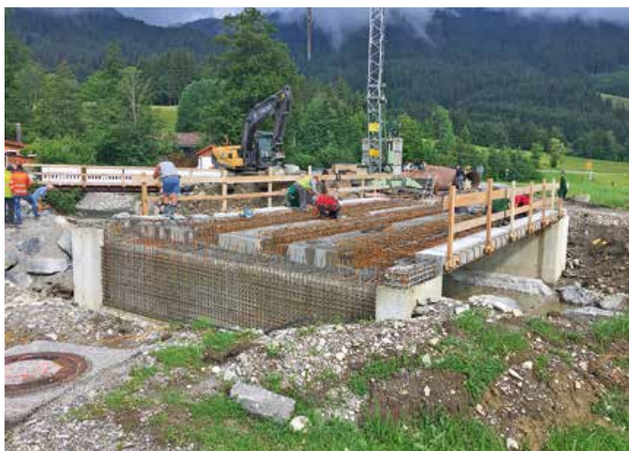
Neubau der Wertachbrücke in Unterjoch.
