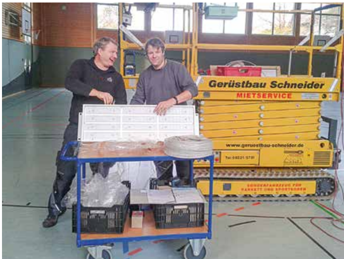
Frank Thiel und Alexander Ammann bei der Umrüstung der Turnhallenbeleuchtung.
