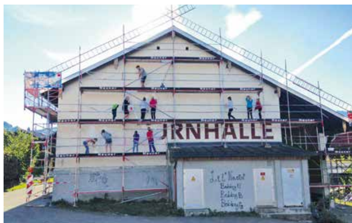
Sanierung der Vereinsturnhalle.
