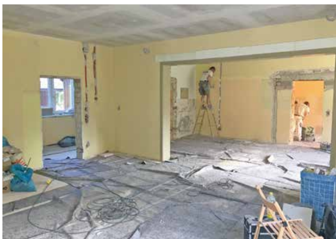
Kindergarten Unterjoch – Bauarbeiten innen.
