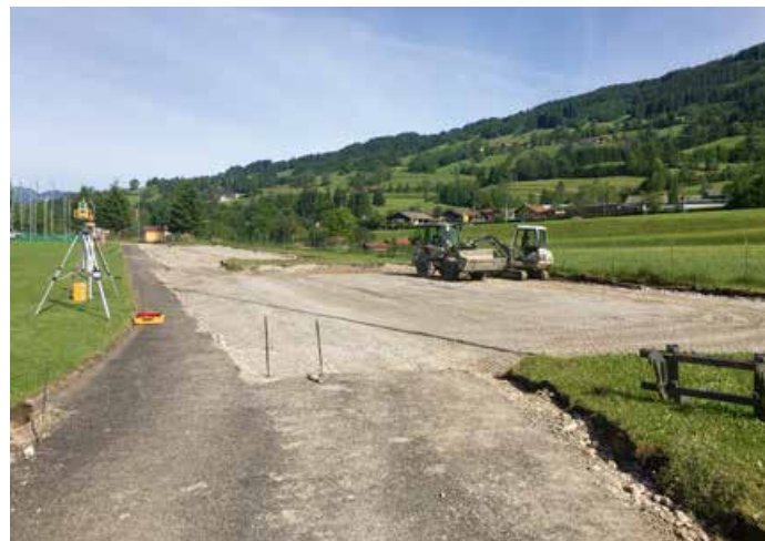
Sanierungsarbeiten am Sportplatz.
