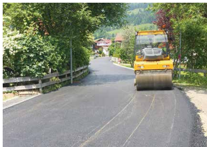
Teearbeiten in der Hintersteiner Straße.
