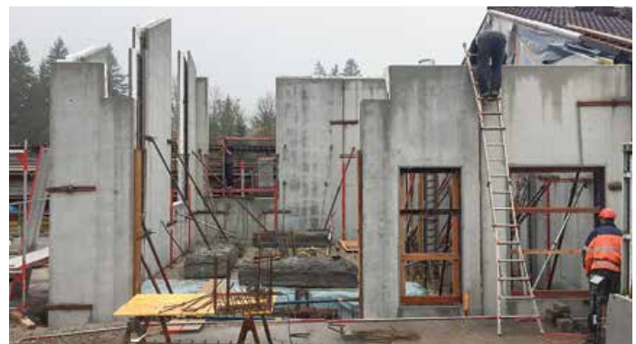
Rohbau der Waschhalle im Bauhof.
