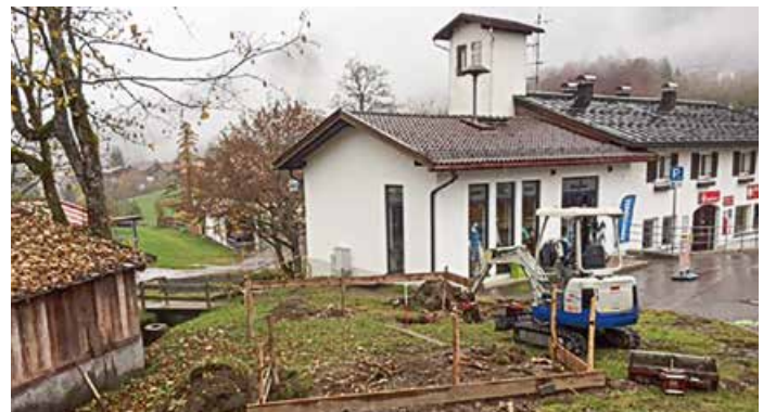
Toilettenanlage in Oberjoch.
