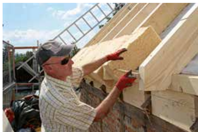
Ein Dämmung – wie hier aus Holzfasern – sorgt für sommerlichen Wärmeschutz. Bild: eza!
