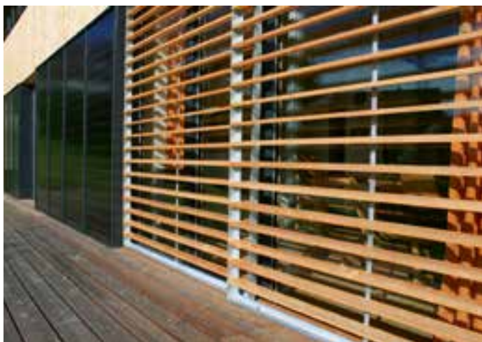
Ein außen montierter Sonnenschutz sorgt im Sommer für angenehme Temperaturen im Haus. Bild: eza!
