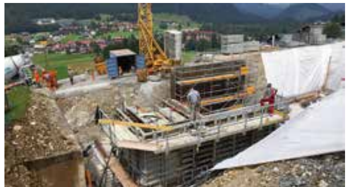
Bauarbeiten zur Erweiterung des Wasser-Hochbehälters in Oberjoch.
