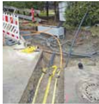
Breitbandkabel wird verlegt.
