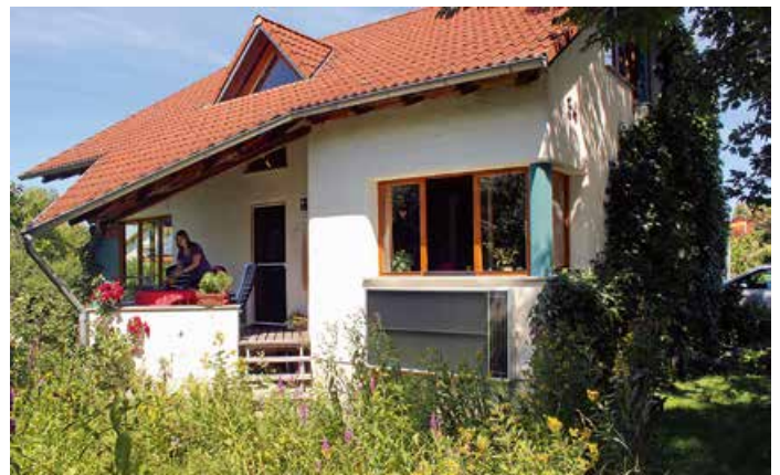
Mit Hilfe von solaren Luftkollektoren kann die Schimmelbildung in Kellern verhindert werden. Foto: Grammer Solar
