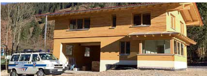
Bergrettungswache Hinterstein im Rohbau
