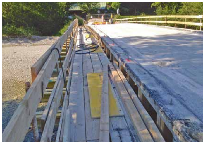
Sanierung der Ostrachbrücke am „Grüebplätzle“.
