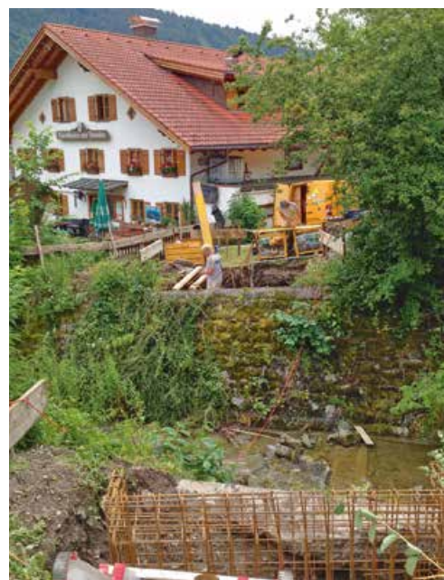
Fußgängersteg in Vorderhindelang.
