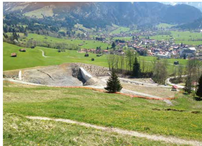
Bau der Murgangssperre abgeschlossen.
