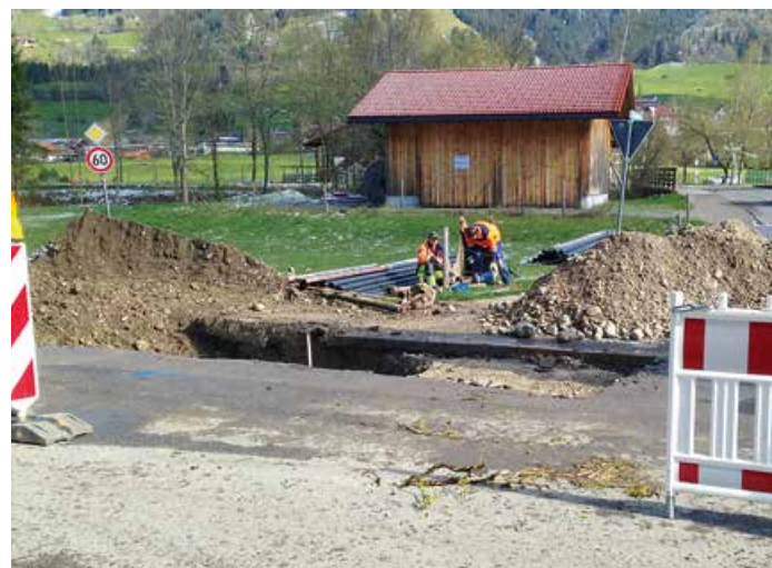
Wasserleitung an der OA 28 saniert.
