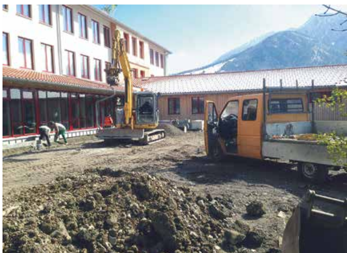
Arbeiten im Pausenhof der Grund- und Mittelschule.
