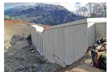
Bauarbeiten an der Murgangssperre Zillenbach
