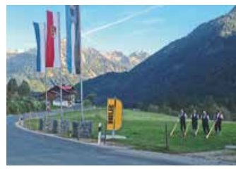
Asphaltierungsarbeiten an der OA 28 abgeschlossen
