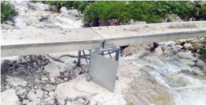
Brücke über den Stierbach.
