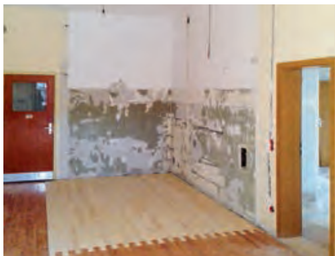
Umbauarbeiten im Kindergarten Hinterstein.
