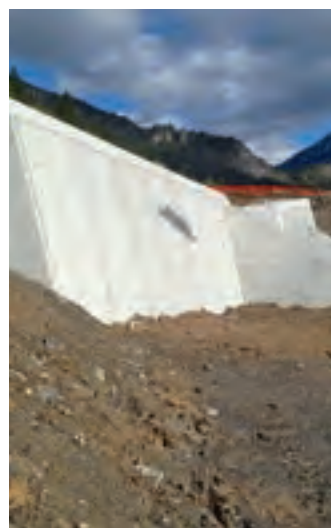
Murgangssperre am Zillenbach.
