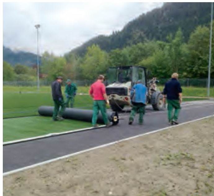
Fertigstellung des neuen Kunstrasenplatzes.
