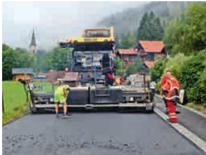
Die Asphaltierungsarbeiten im Bereich der Ortsdurchfahrt Hinterstein – OA 28 sind abgeschlossen und der neue Straßenabschnitt für den Verkehr freigegeben. Derzeit laufen die Arbeiten an den Zufahrten und Randbereichen sowie die Erneuerung der Straßenbeleuchtung.
