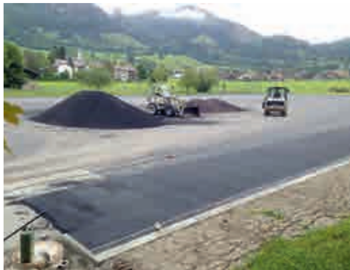
Beim Kunstrasenplatz Bad Hindelang ist eine elastische Tragschicht auf dem vorbereiteten Unterbau eingebaut worden. Nun erfolgt die Verlegung des Kunstrasenbelages.
