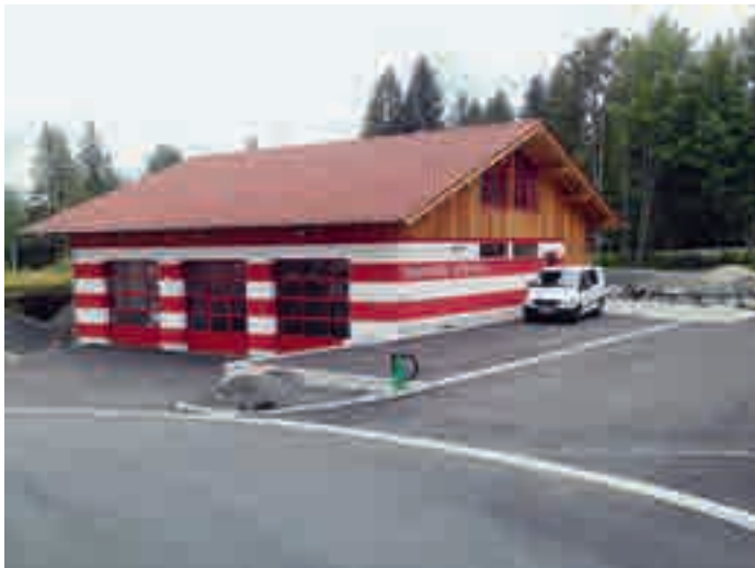
Der Neubau des Feuerwehrhauses in Oberjoch steht kurz vor der Gesamtfertigstellung. (Bilder: MBH)
