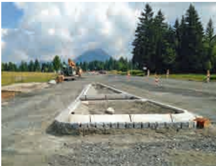
Am Kreisverkehr an der B 308 / B 310 in Oberjoch wird derzeit mit Hochdruck gearbeitet. Ab dem 9. September 2013 ist der Knotenpunkt für den Verkehr wieder befahrbar.
