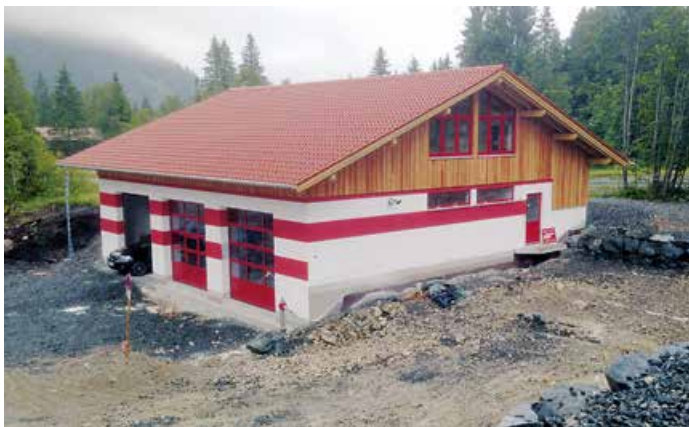
Neubau Feuerwehrhaus Oberjoch.
