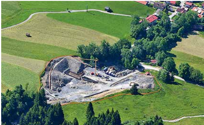
Bauarbeiten an der Murgangssperre am Zillenbach.
