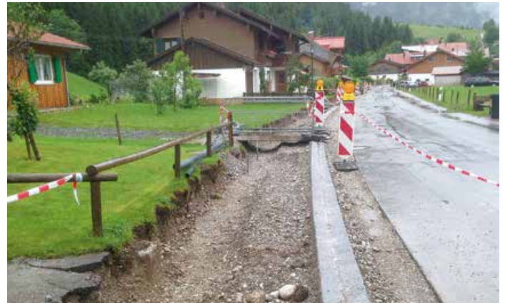
Generalsanierung der Ortsdurchfahrt Hinterstein.
