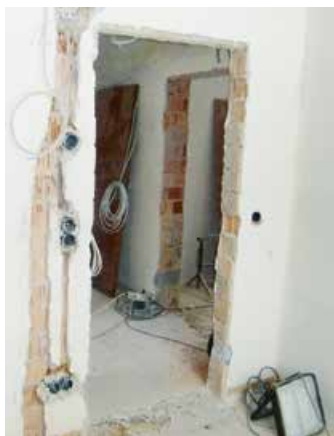
Umbauarbeiten. Bilder: MBH
