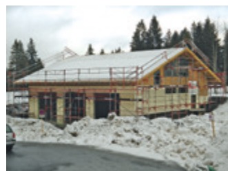
Feuerwehrhaus Oberjoch im Rohbauzustand. (Bild: MBH)
