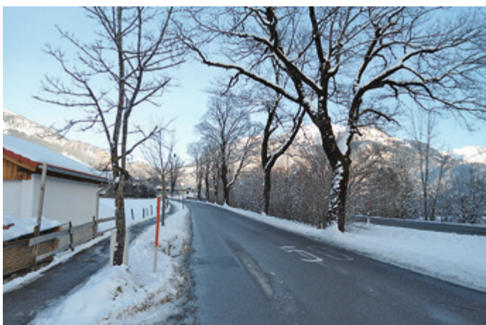
Sonthofener Straße vor Beginn der Arbeiten.
