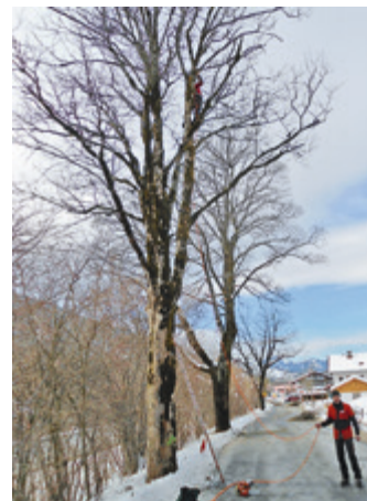
Totholzentfernung zur Herstellung der Verkehrssicherheit.
