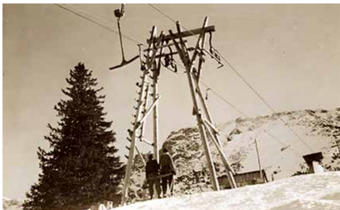
Beide Aufnahmen: Ski-Nostalgie pur – vor 70 Jahren wurde der erste Ski-Lift Deutschlands am Iseler gebaut und in Betrieb genommen.
