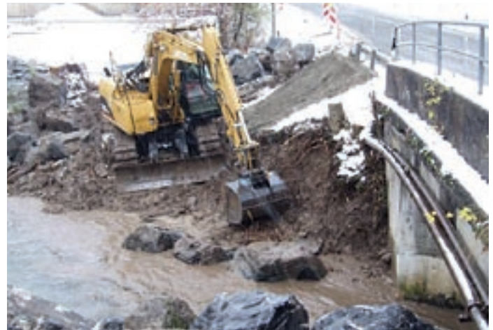
Bau der Widerlager für den Holzsteg über den Hirschbach.
