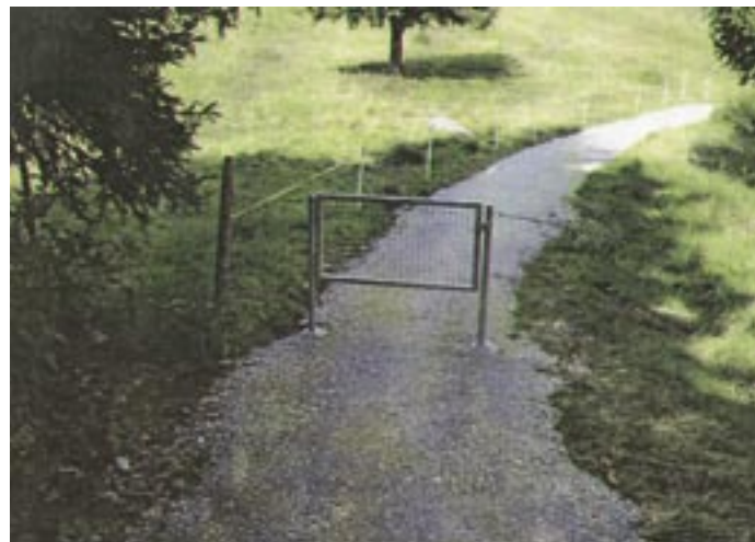
Selbstschließender Fußgängerdurchlass am Kanzelrundweg
