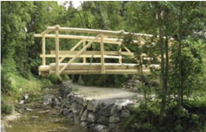
Die neue Brücke wird über den Pfunzenbach gehoben.
