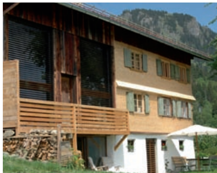
Die neue Südfassade.
