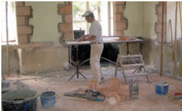
Umfangreiche Bauarbeiten im Bürgermeisterbüro.
