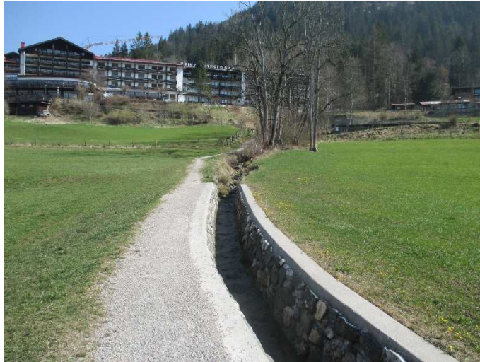
Bild 3: Übergang des Naturgerinnes unterhalb des Prinz-Luitpold Bads in das hart ausgebaute gemauerte Gerinne (Blick gegen die Fließrichtung)
