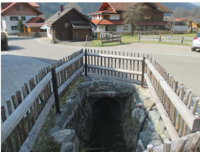
Bild 8: Einlauf in die zweite Ver- rohrung DN1000.
