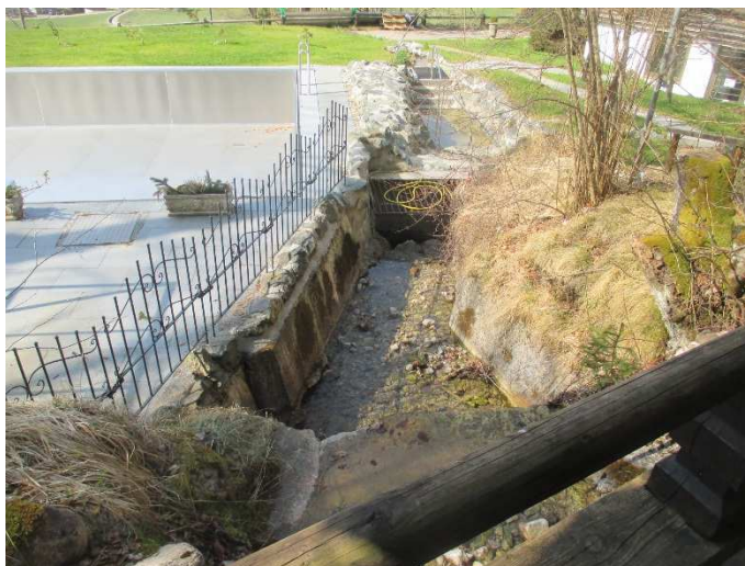
Bild 2: Einlauf in die Verrohrung beim Prinz-Luitpold Bad, Blick in Fließrichtung
